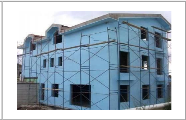
Şekil 170: Yalıtım malzemesi uygulaması
